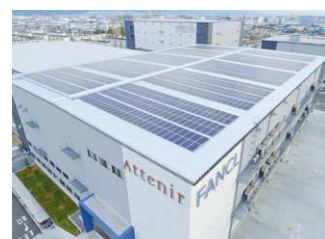
関西物流センターの太陽光パネル (2021年6月設置)
